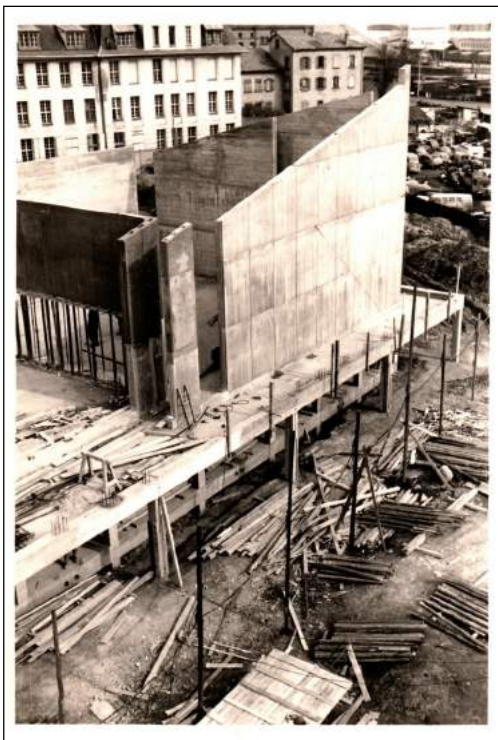
Les travaux avancent. Au fond les bâtiments de la Légion étrangère
